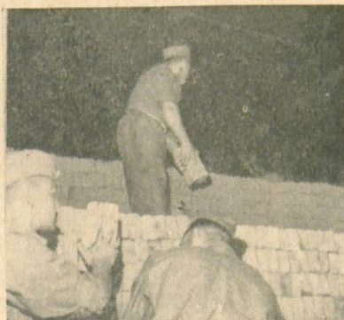
Enforcamento de tijolos.
