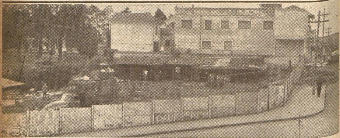
Aspectos de terrenos onde serão instaladas novas estações
