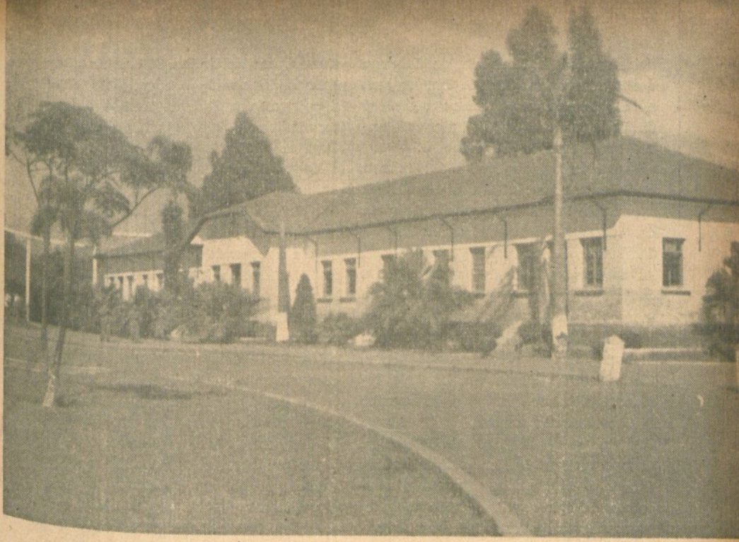
Instalações da av. Cruzeiro do Sul.
