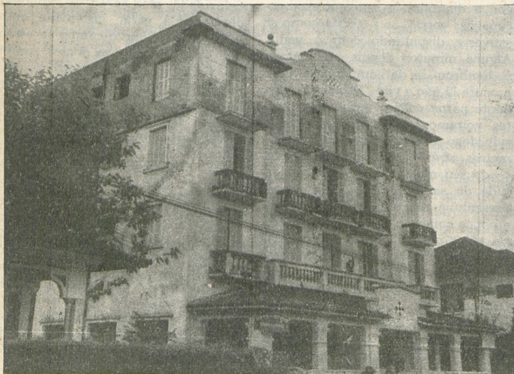
Vista da fachada do prédio da Colônia de Férias, em construção
